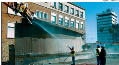
▶ Una grua enderroca l'últim mur de l'antic túnel que encara existia.
